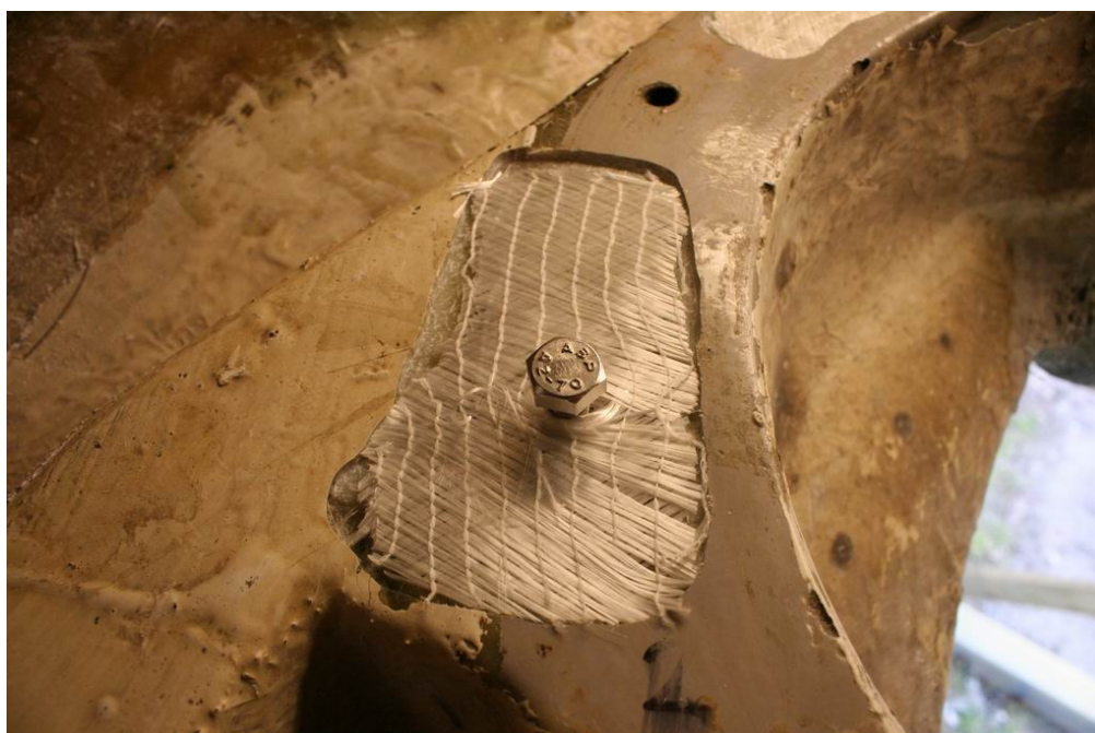
Et enkelt lag glasfiber for bedre vedhæftning og styrke.
